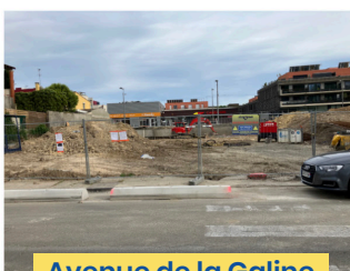
Avenue de la Galine 77 logements
